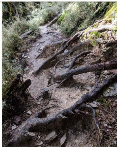
4k+330 路徑凹陷、樹根裸露處 | 路基土石回填、砌石護坡、圓木護坡
