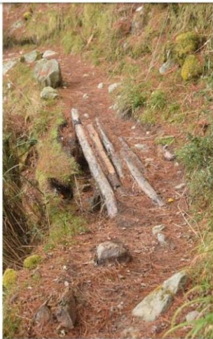
3k+070 路基毀損 | 半邊橋 (長4m、寬1.2m)
