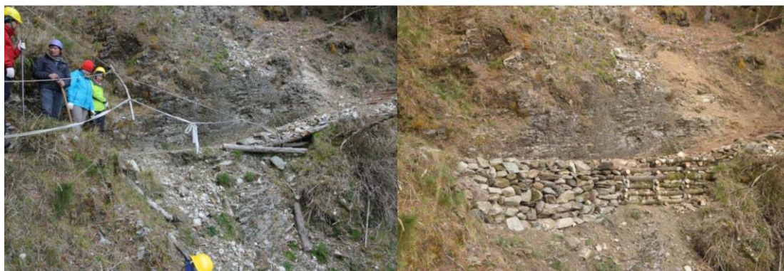
3k+050 颱風崩坍處 | 砌石駁坎、格框護坡 (長3.8m /2.6m、寬1.3m、高1.1m)
