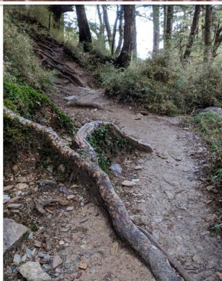
4k+330 路徑凹陷、樹根裸露處 | 路基土石回填、砌石護坡、圓木護坡
