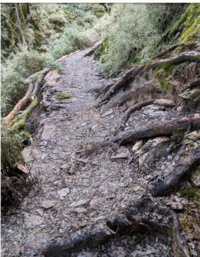
4k+330 路徑凹陷、樹根裸露處 | 路基土石回填、砌石護坡、圓木護坡
