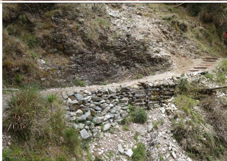
3k+050 颱風崩坍處 | 砌石駁坎、格框護坡 (長3.8m /2.6m、寬1.3m、高1.1m)
