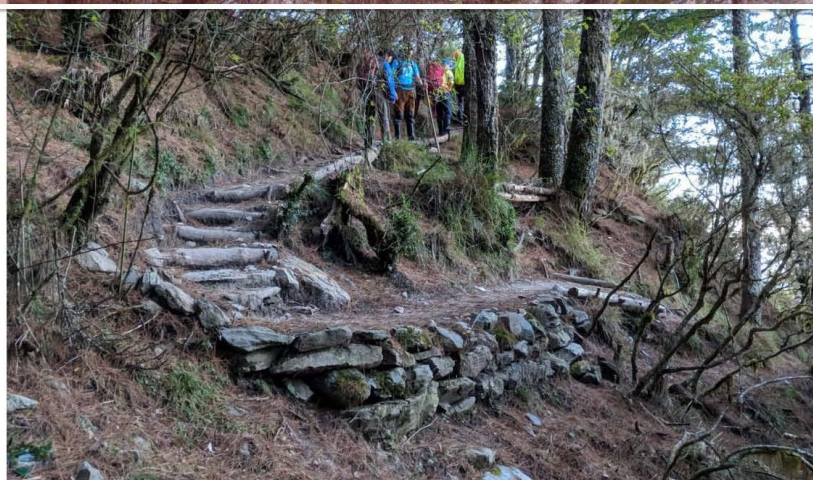
3k+270 抄截徑陡升且樹根裸露處 | 改道，施作回頭彎 (switch back) 以砌石護坡、土石階、土木階、圓木護坡，採之字形緩上
