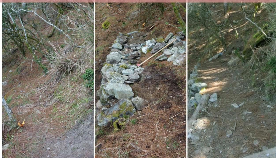
3k+270 抄截徑陡升且樹根裸露處 | 改道，施作回頭彎 (switch back) 以砌石護坡、土石階、土木階、圓木護坡，採之字形緩上
