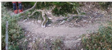
4k+330 路徑凹陷、樹根裸露處 | 路基土石回填、砌石護坡、圓木護坡
