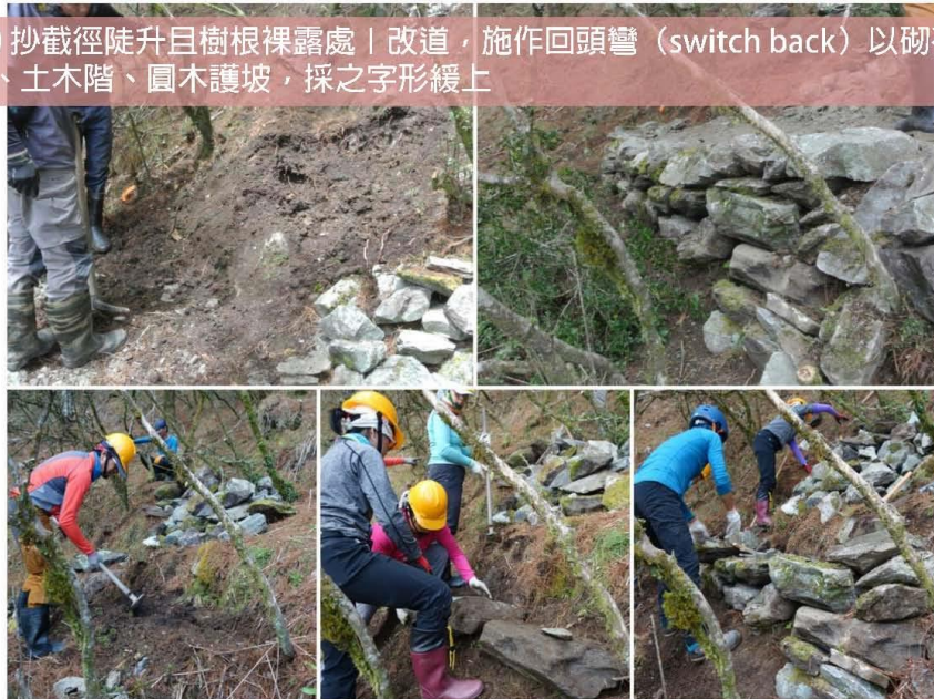
3k+270 抄截徑陡升且樹根裸露處 | 改道，施作回頭彎 (switch back) 以砌石護坡、土石階、土木階、圓木護坡，採之字形緩上
