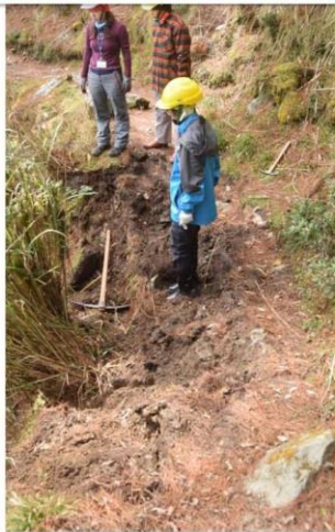
3k+070 路基毀損 | 半邊橋 (長4m、寬1.2m)
