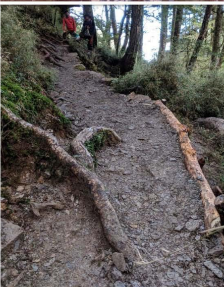
4k+330 路徑凹陷、樹根裸露處 | 路基土石回填、砌石護坡、圓木護坡
