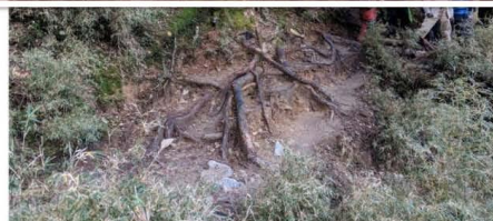
4k+330 路徑凹陷、樹根裸露處 | 路基土石回填、砌石護坡、圓木護坡
