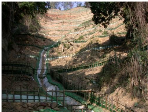
裸坡整坡與排水溝處理範例 1
