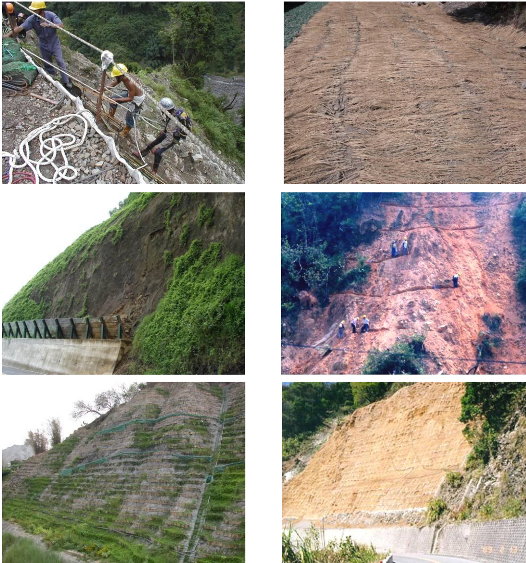
圖 2-8 崩塌地植生處理相關照片
