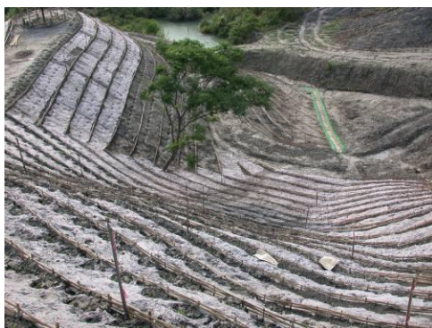
裸坡整坡與排水溝處理範例 2
