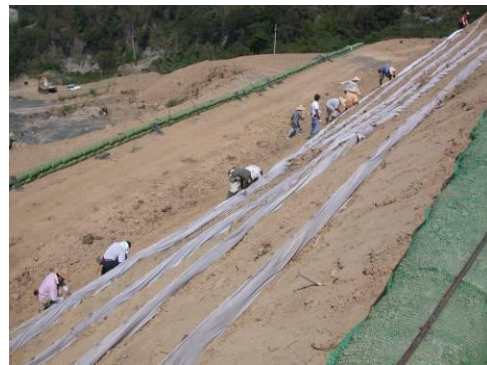
裸坡整坡處理範例
