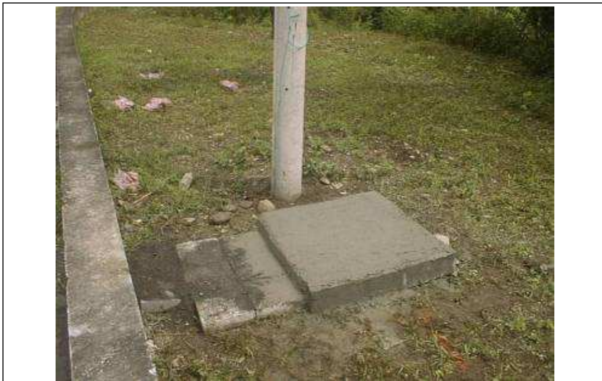
圖附錄 3-18 觀測小屋基地建置
