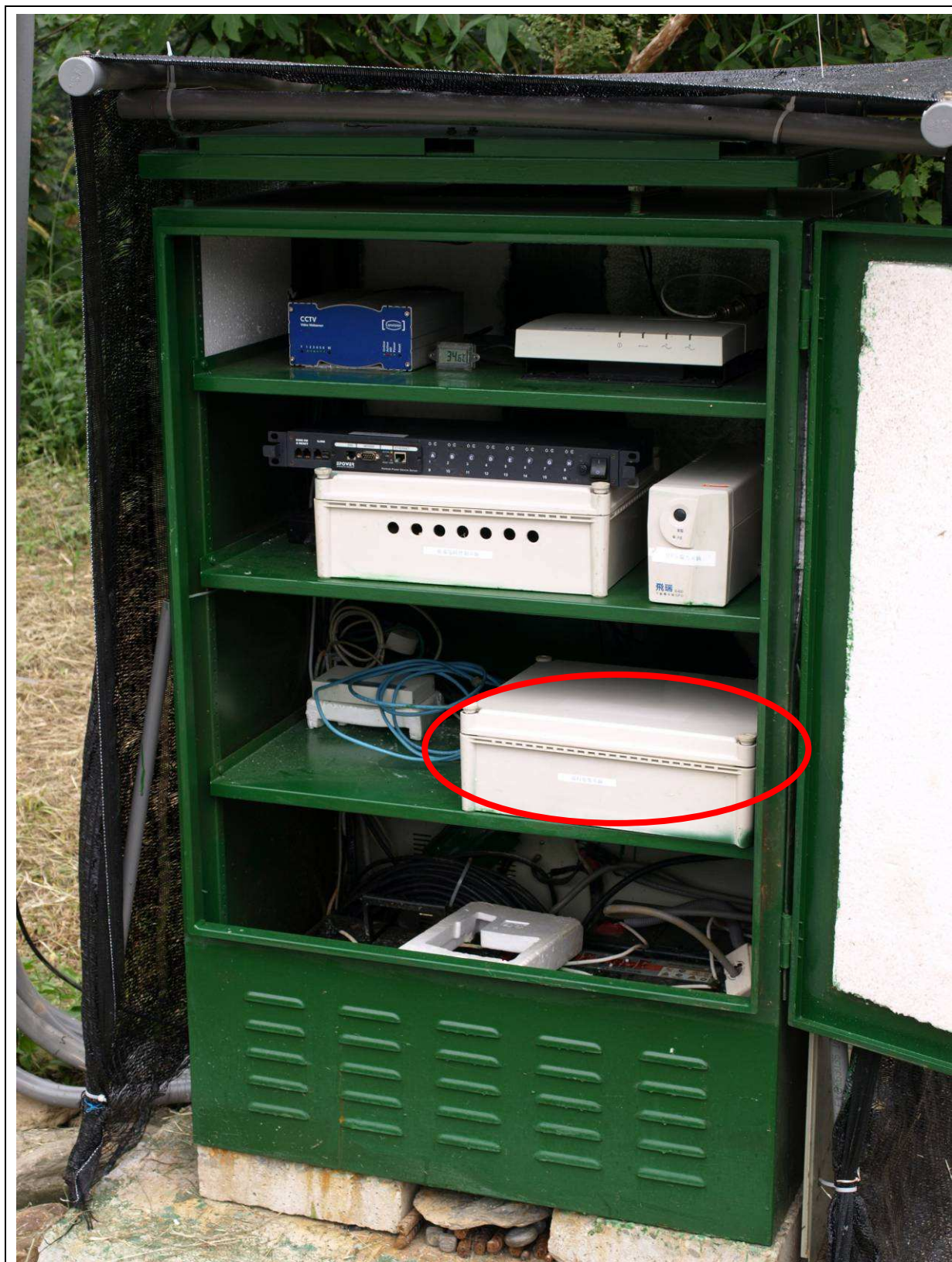
圖附錄 3-15 GSM 無線傳輸設備
