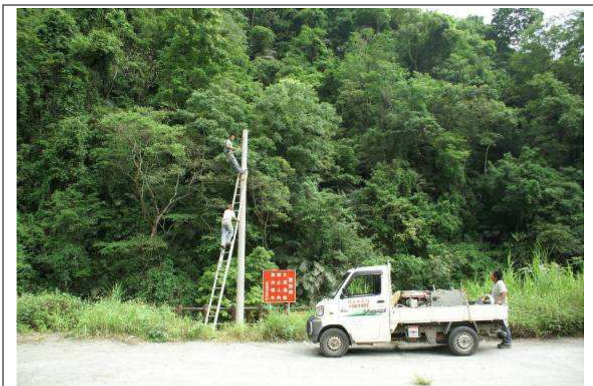
圖附錄 3-3 攝影機電桿架設工程
