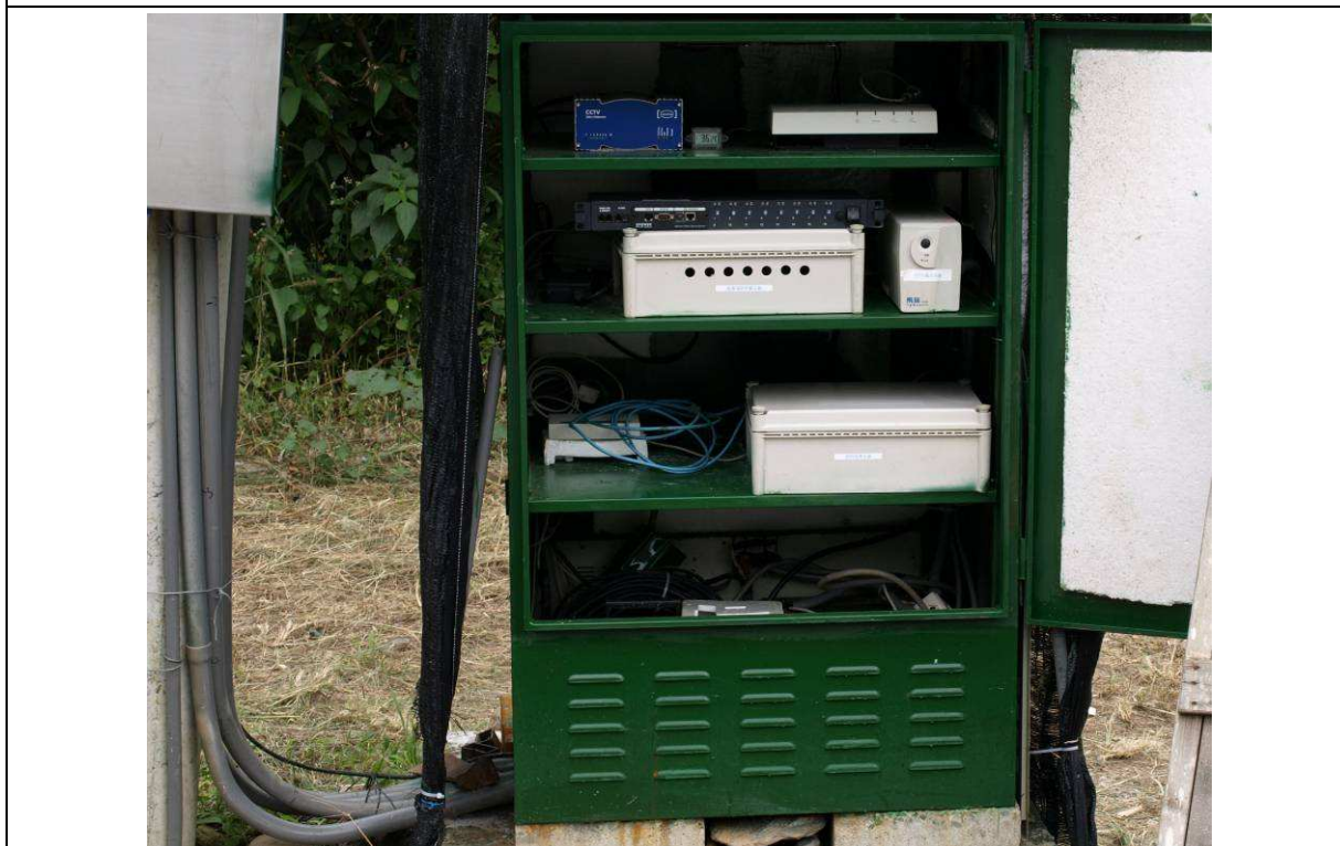
圖附錄 3-19 觀測小屋內部陳設
