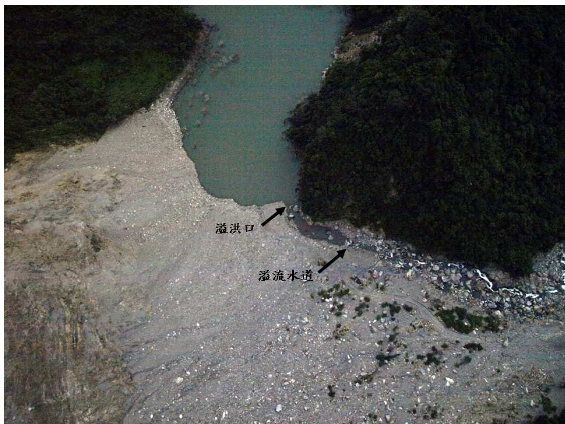
圖 5-3-2 堰塞湖區空拍照片(溢洪口降低後)
