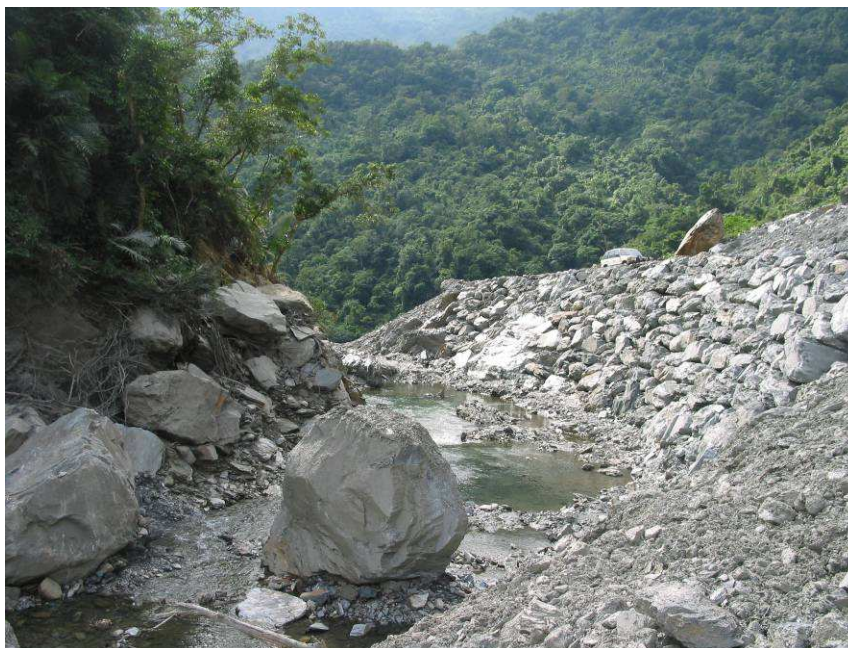
圖 5-3-3 溢流道修整後現況照片(張蘇能攝)
