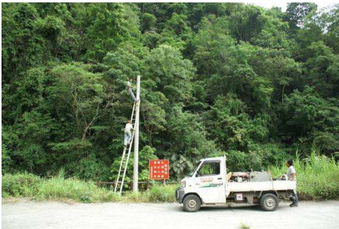
圖 3-1-4 攝影機電桿架設工程
