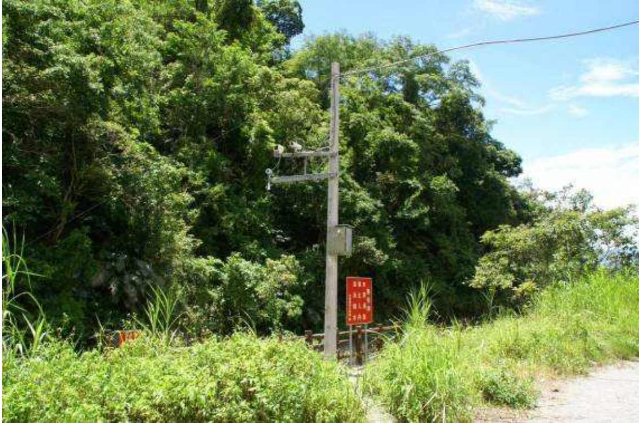
圖 3-1-5 一號攝影機、紅外線投射燈架設圖
