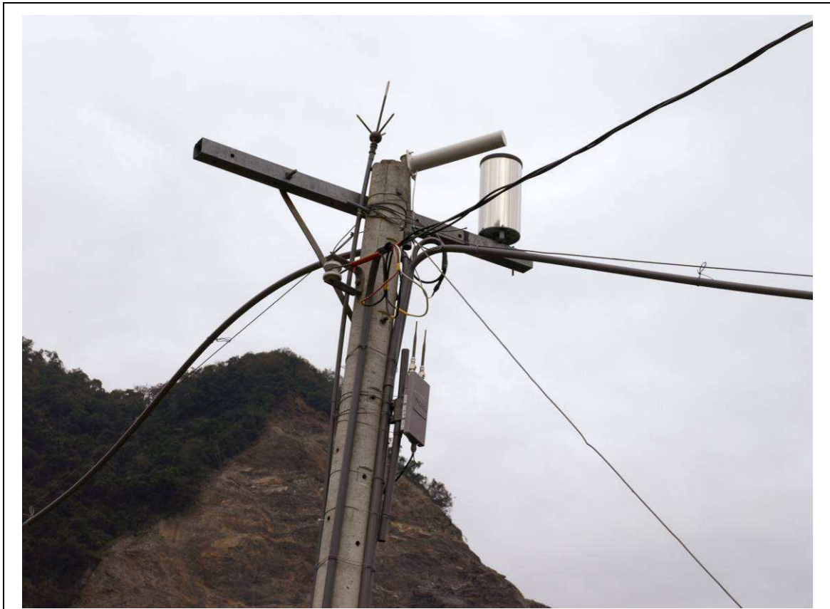
圖 3-4-7 苗圃上方無線傳輸發送端設備
