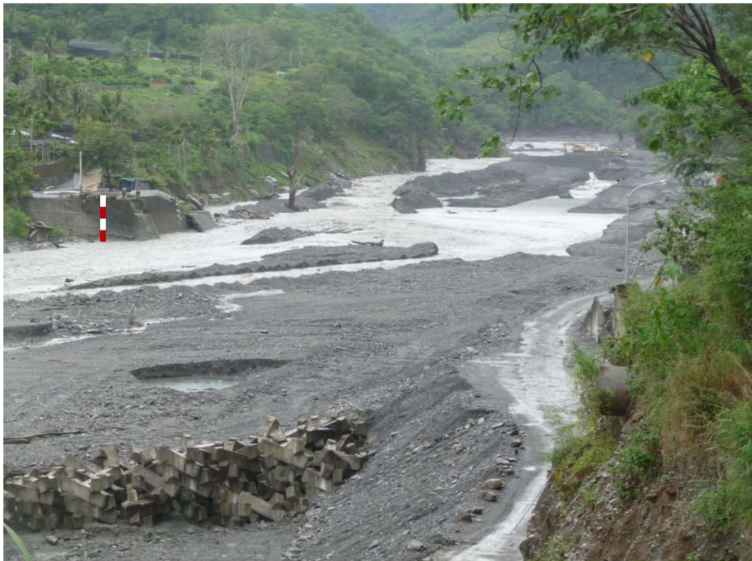
圖8-4.2 舊嘉蘭橋台人工監測水尺示意圖
