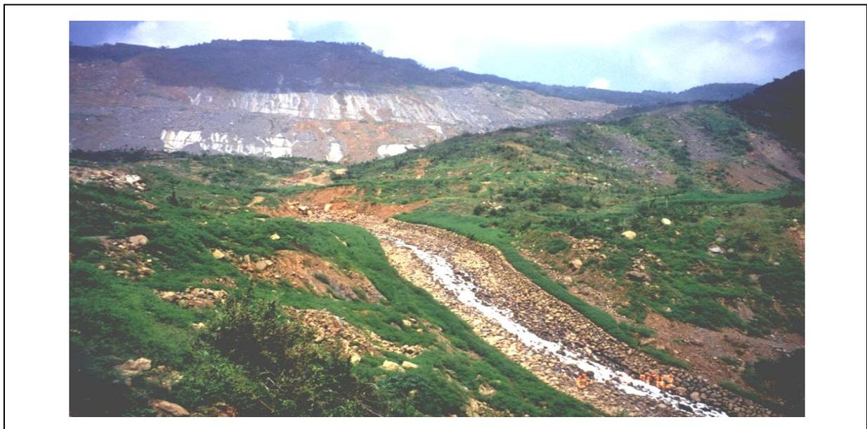
圖7-3.2 溢流水道塊石鋪底及邊坡整坡
