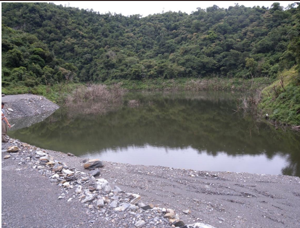
土方未填湖前（98/09，莫拉克颱風後）
