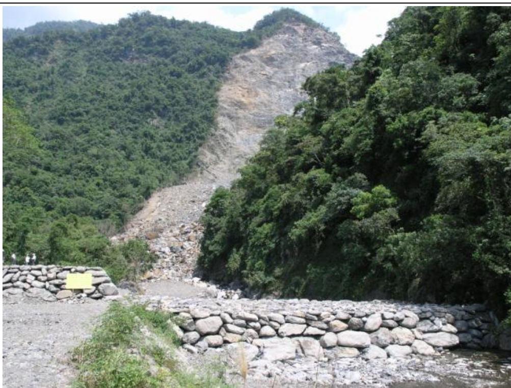
緊急工程實施後 (95/09/05)
