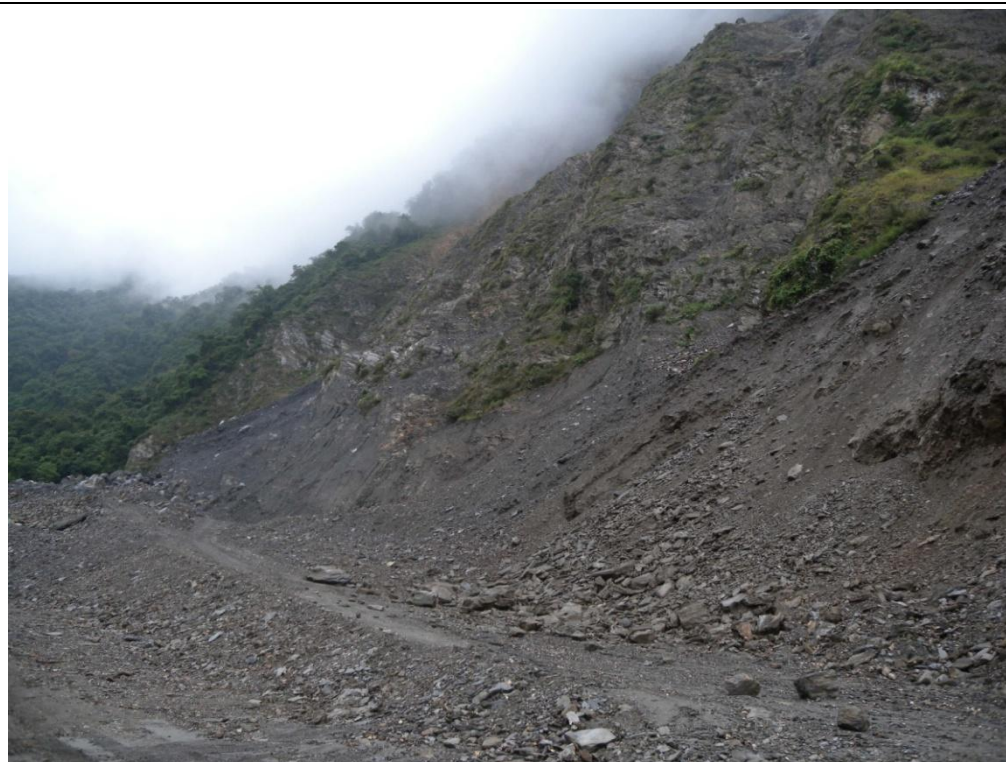
崩積土體挖除後（99/06）
