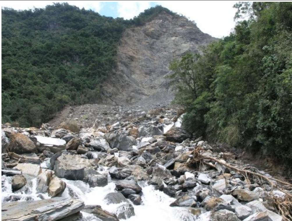
緊急工程實施前 (95/07/31)
