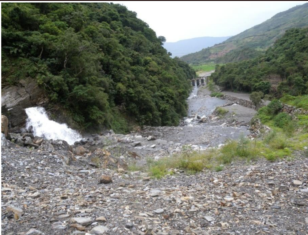
施工前（98/09，莫拉克颱風後）
