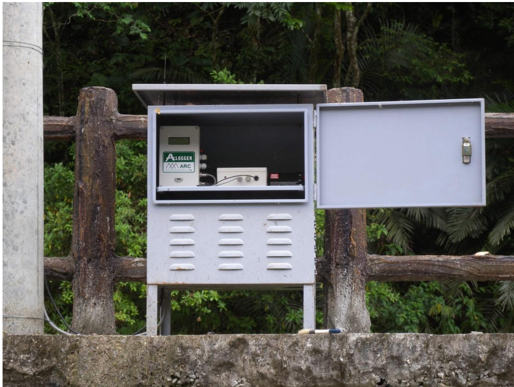
圖 3-3.7 水位計觀測小屋完工（4 月 6 日）
