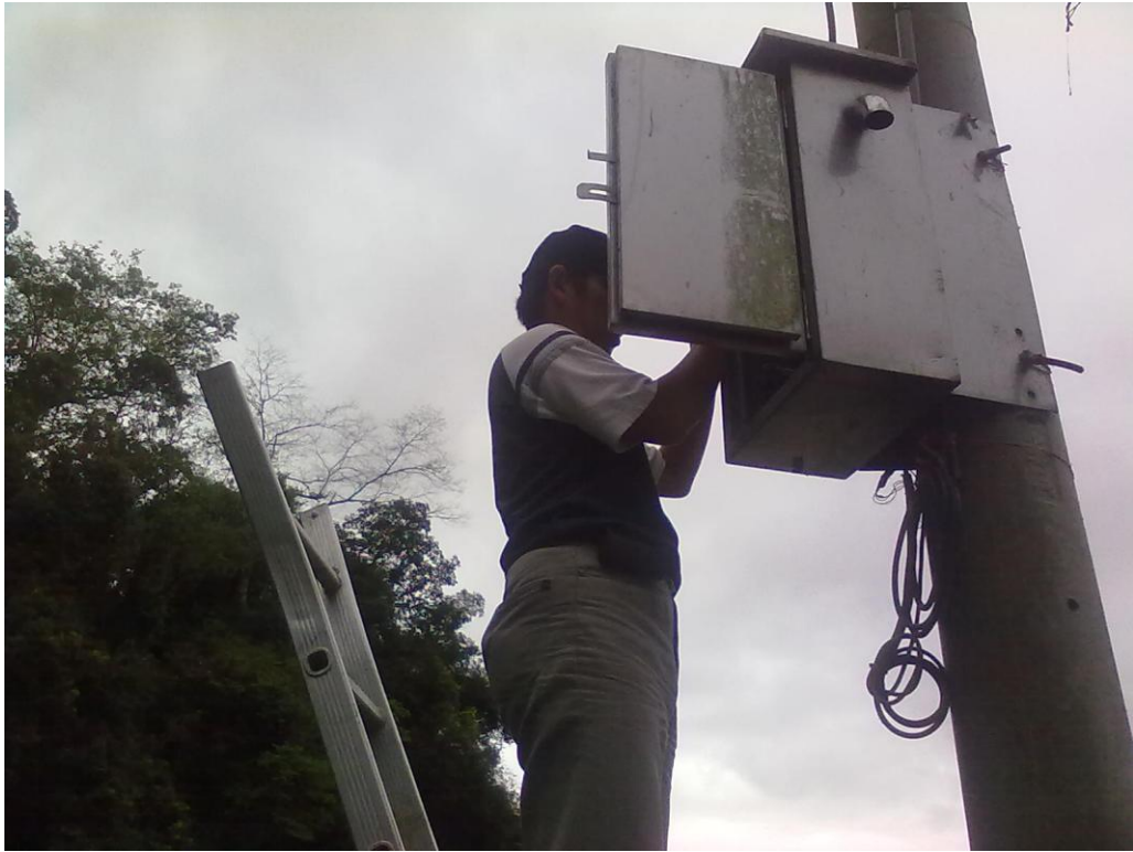
圖 3-3.4 確定電桿儀器箱內的市電線路（4 月 6 日）
