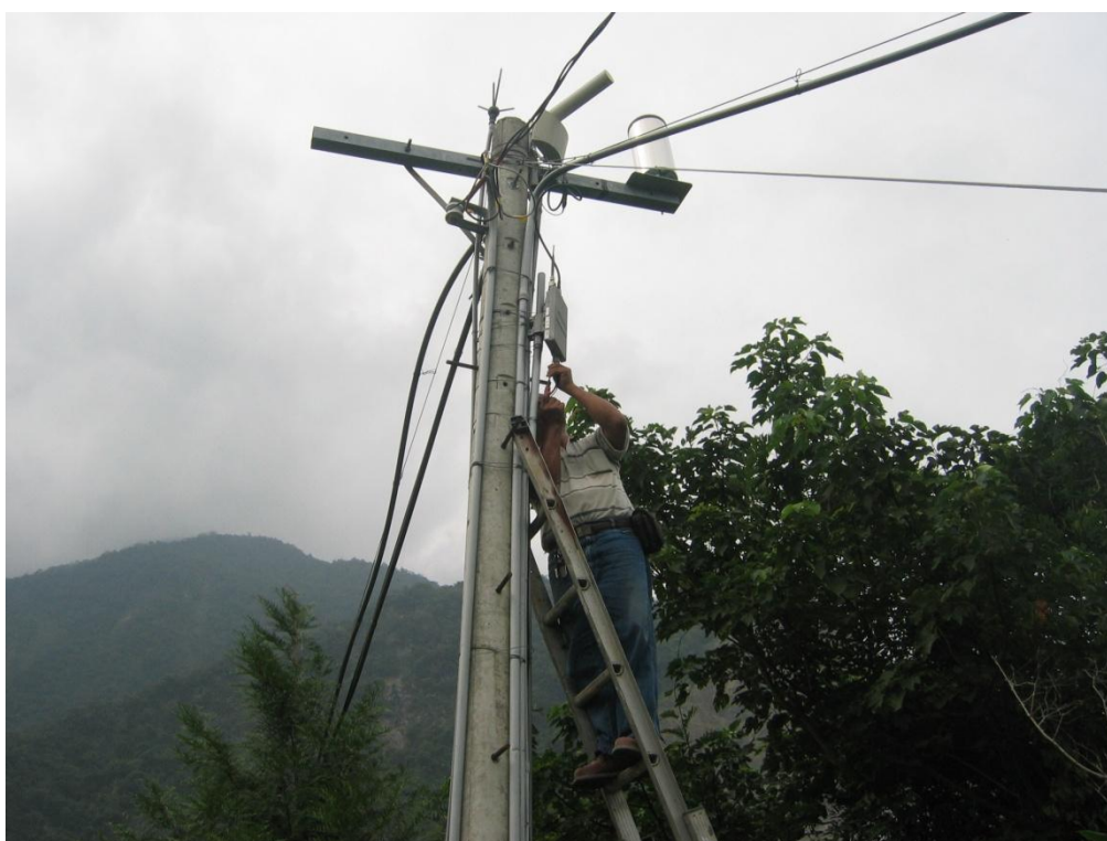
圖 3-3.24 在苗圃觀測小屋施作無線 AP 檢測與更換工作情形（9 月 18 日）
