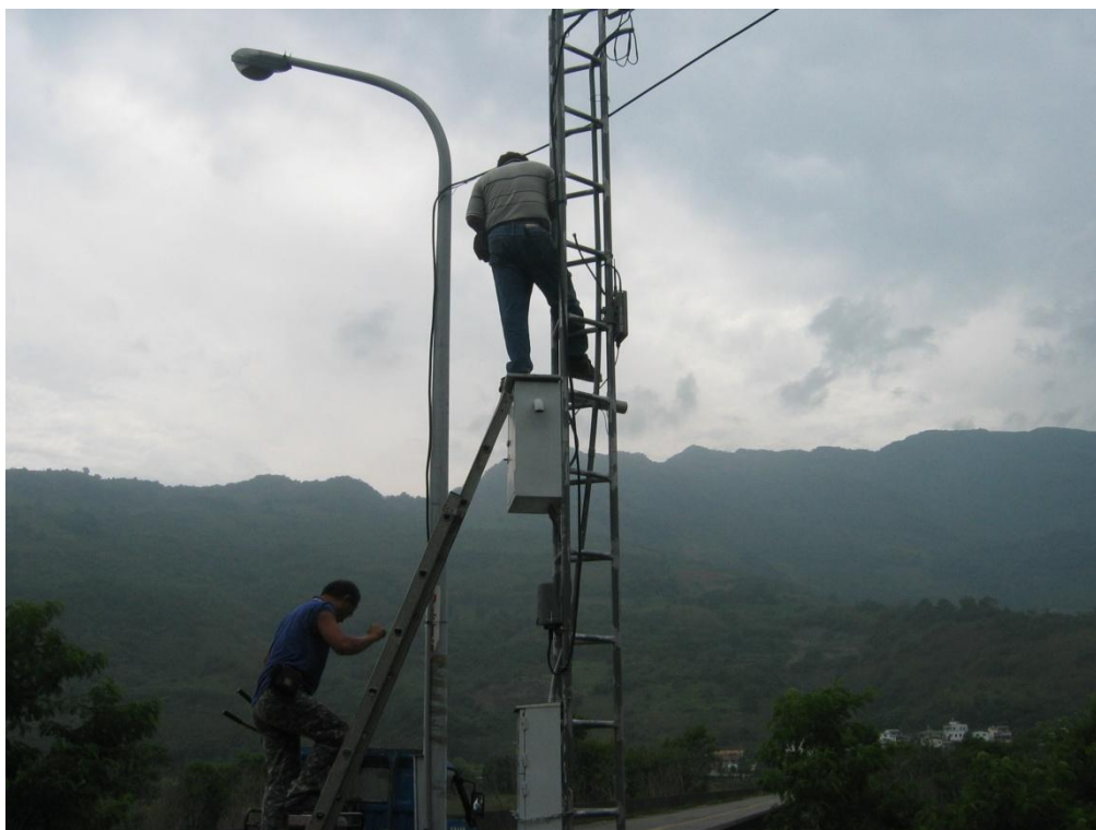
圖 3-3.23 在大龍橋中繼站施作無線 AP 檢測與更換工作情形（9 月 18 日）
