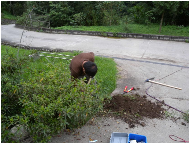
圖 3-3.14 雨量筒支架架設 (6 月 25 日)
