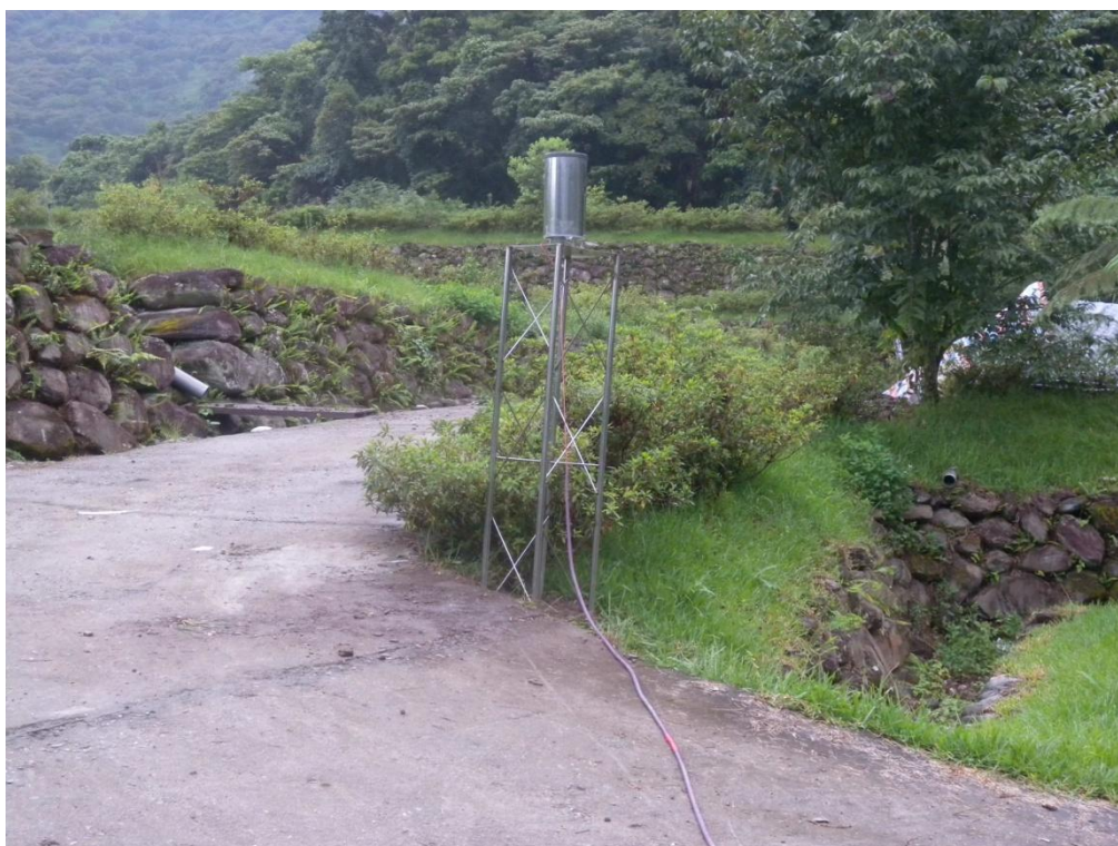
圖 3-3.18 雨量筒完工（6 月 25 日）
