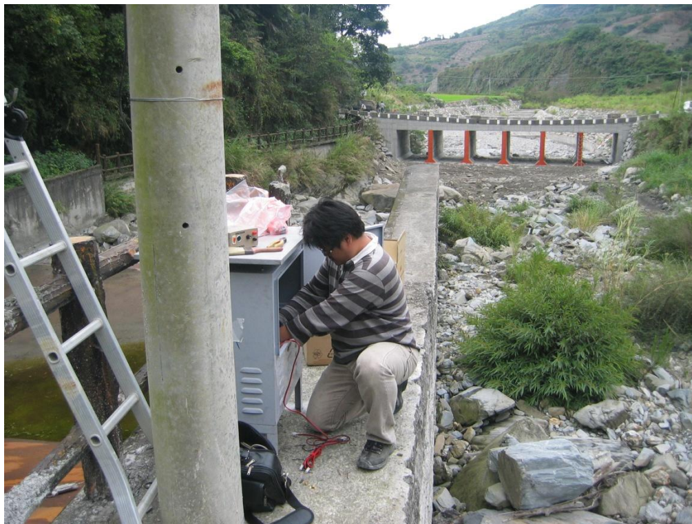
圖 3-3.5 安裝儀器箱（4 月 6 日）
