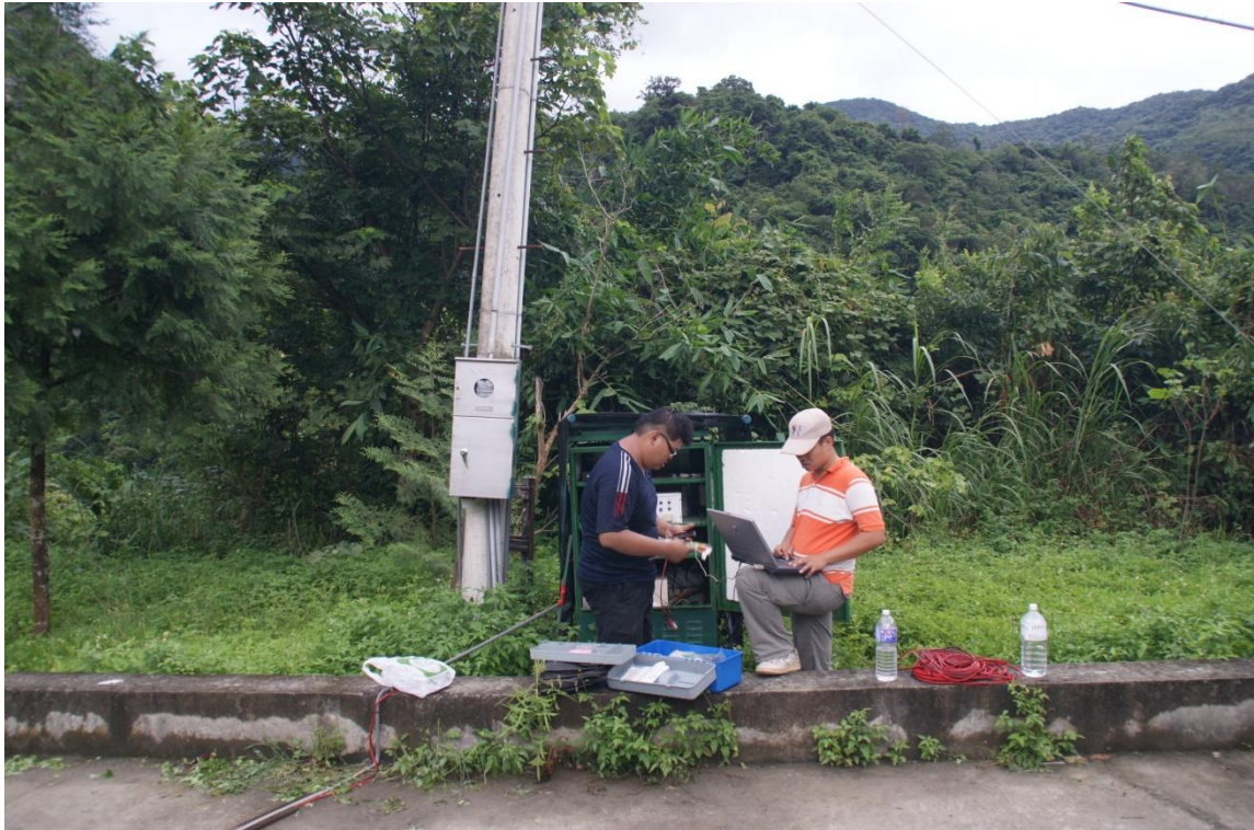
圖 3-3.19 雨量筒線路檢測與維護（7 月 16 日）
