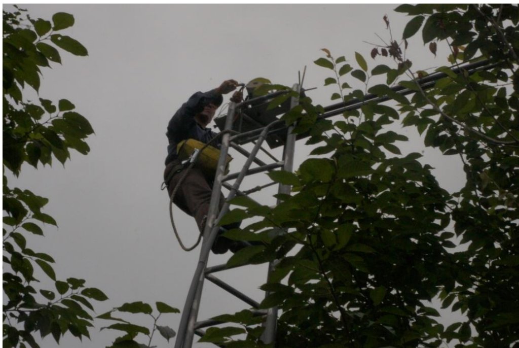
圖 3-3.20 二號攝影機更換線路工作情形（4 月 26 日）
