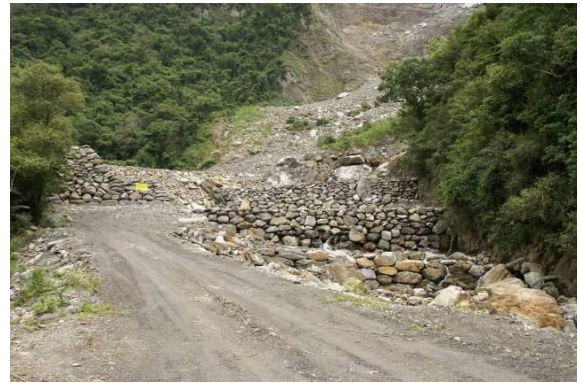
下游河道之變化(2) (民國 98 年，壩趾工已完工)
