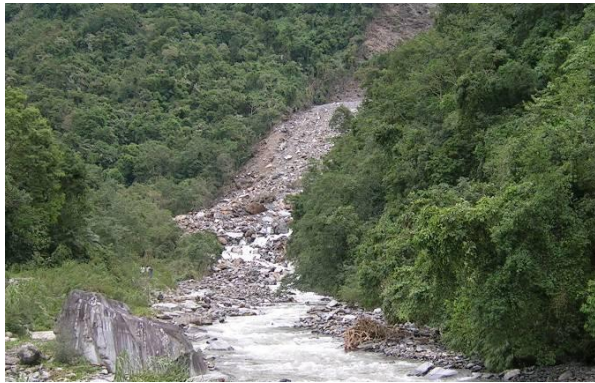
下游河道之變化(1) (民國 95 年，尚未施作壩趾工)
