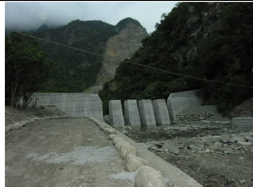
下游河道之變化(3) (民國 98 梳子壩已完工)
