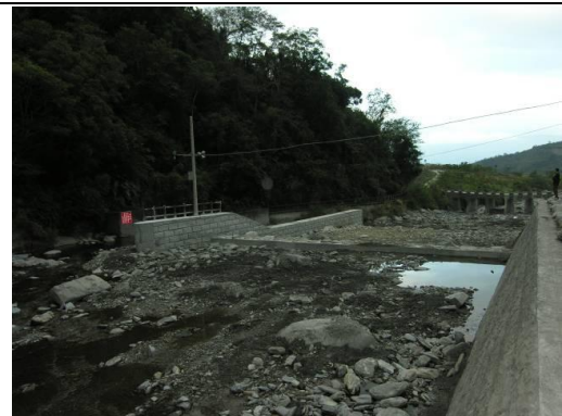
下游河道之變化(2) (民國 98，護岸與整流工已完工)
