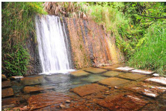
瓦崗溪中段的一處攔沙壩
